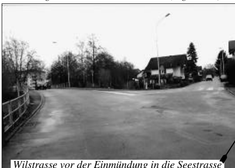
Wilstrasse vor der Einmündung in die Seestrasse
