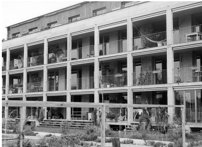
Niedrigenergiehaus am Talweg
