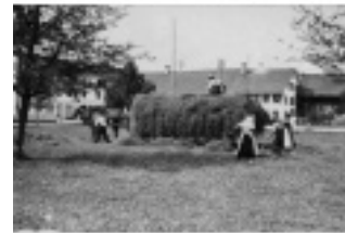
Heute an der Zorichstrasse in Uster, 1900. Heute steht auf der Wiese das Einkaufszentrum Uster 77. Das Gebäude links ist das ehemalige Restaurant Schmiedstube (heute Molino).
