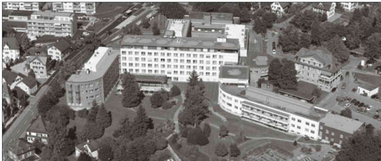
Die heutige bauliche Infrastruktur des Spital Usters ist veraltet und muss deshalb dringend saniert werden.
